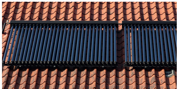
Met zonnecollectoren vang je zonne-energie op en verwarm je water
